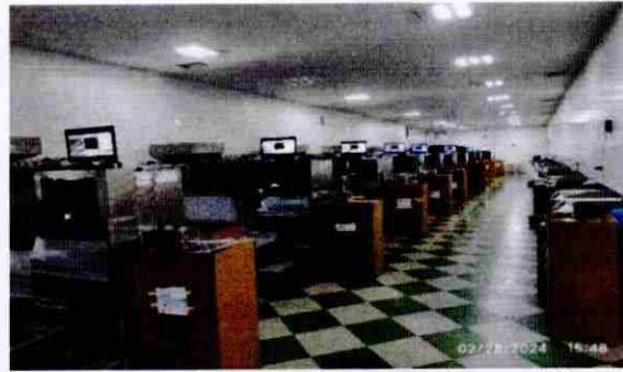
اپوکسی سالن سورت اتوماتیک شماره ۱ قبل از اجرای اپوکسی
