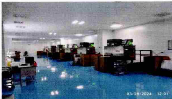
سالن سورت اتوماتیک شماره ۲ بعد از اجرای اپوکسی
