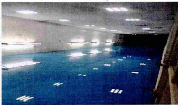
سالن سورت اتوماتیک شماره ۱ بعد از اجرای
